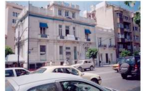
Αποκατάσταση κτηρίου Ν. Γουλανδρή επί των οδών Βασ. Σοφίας 18, Μοιραϊκή και Πλατ. Ρηγάδης (έργο από εξέλιξη)
